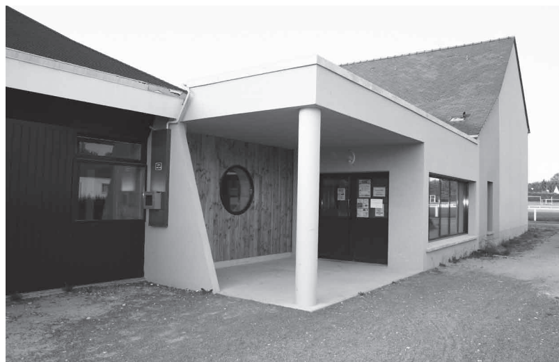
La salle des sports, récemment réhabilitée, fait partie des équipements publics qui répondent aux nouvelles normes d'accès aux personnes handicapées.
